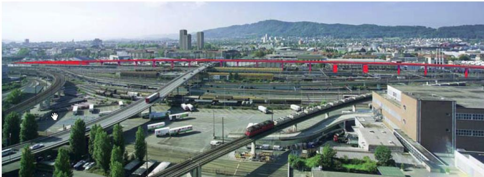
Standort: Hochhaus Pfingstweidstrasse, Blickrichtung Uetliberg. Rot eingefärbt; die Letzigrabenbrücke
